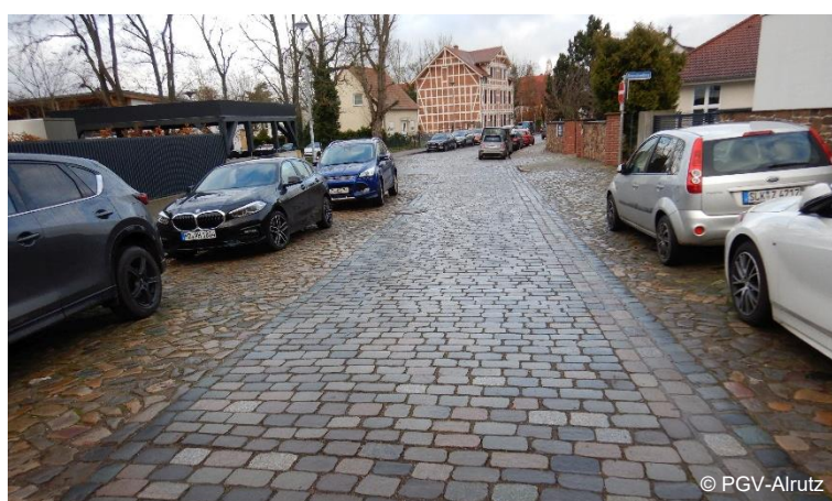
Abb. 4-13: Ortstypischer glatter Pflasterstreifen für Radverkehr in einer Straße mit Kopfsteinpflaster im Zuge des Elberadweges
