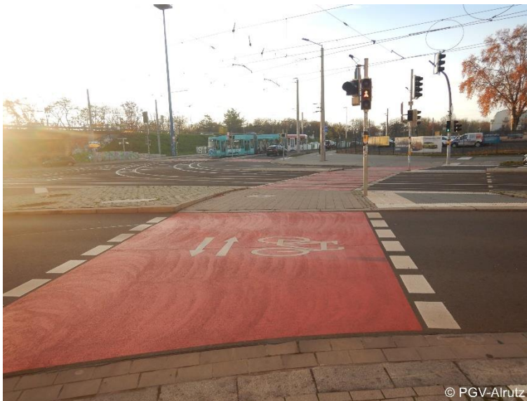
Abb. 4-9: Zweirichtungsradweg mit deutlich markierter Radverkehrsfurt (Beispiel Magdeburg)
