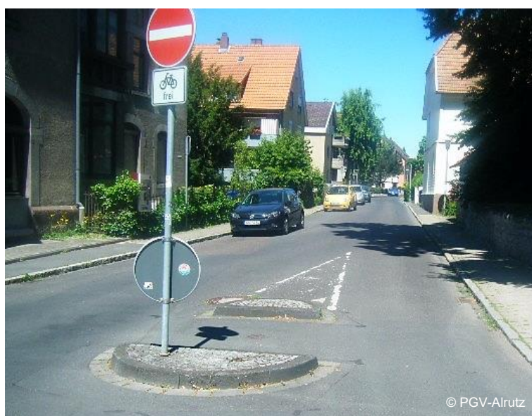
Abb. 4-16: Zugelassener Radverkehr gegen Einbahnrichtung mit „Einfahrtpforte“
