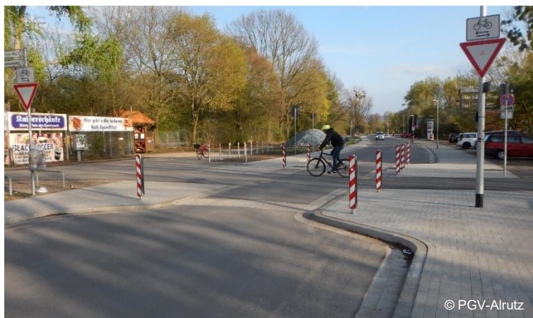
Abb. 4-25: Betonung des Vorrangs der Radverkehrsverbindung durch deutliche Fahrbahneinengung und Aufpflasterung
