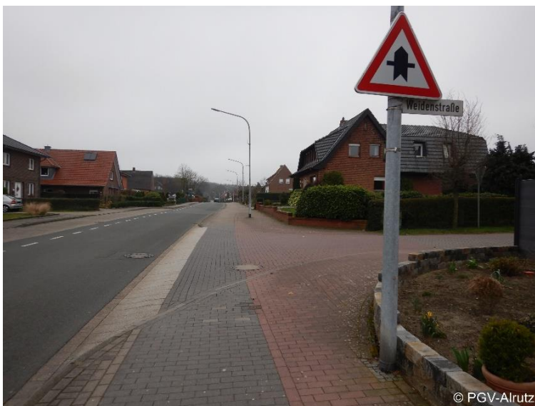
Abb. 4-20: Rad- und Gehwegüberfahrt mit Rampenstein
