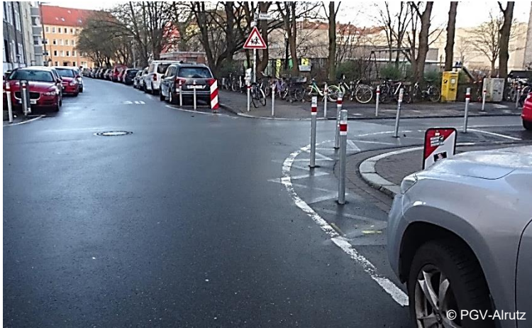
Abb. 4-19: Freihalten der Eckbereiche eines Rechts-vor-Links-Knotenpunktes durch Pfosten
